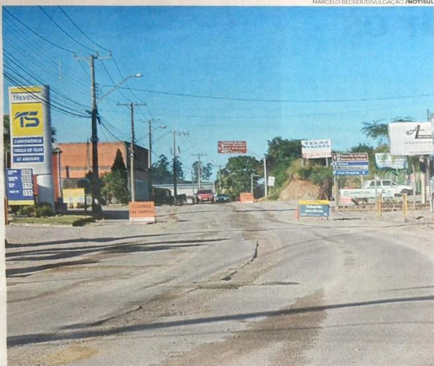
Os trabalhos na via de acesso Sul da cidade terão início nos próximos dias
